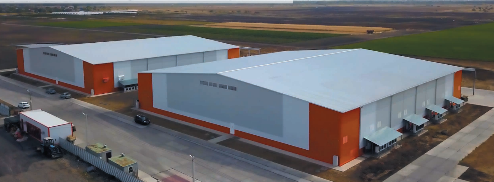
РОССИЯ, КРАСНОЯРСКИЙ КРАЙ. Модульная станция МЧС
